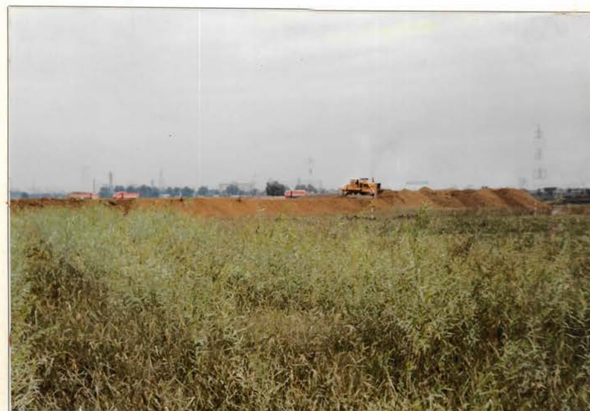
敷地造成全景
