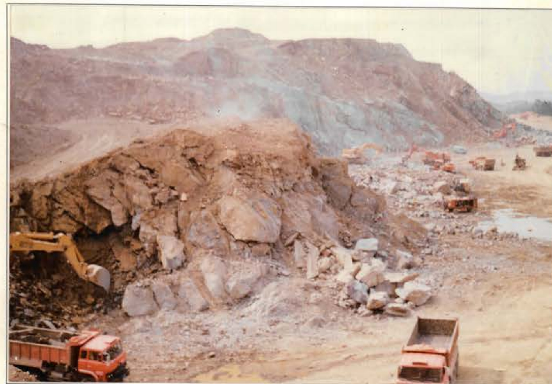
土石採取現場 (2000年12月6日)
