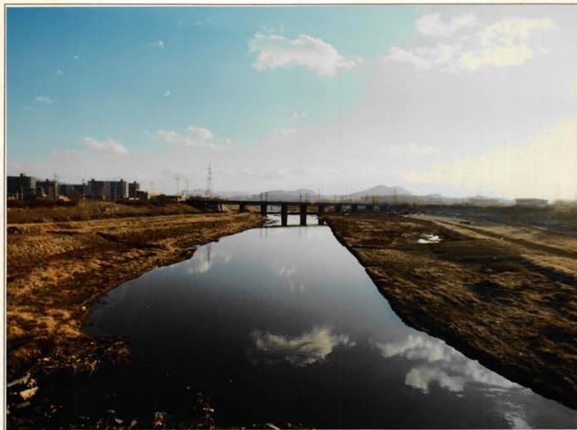
安養川整備前
