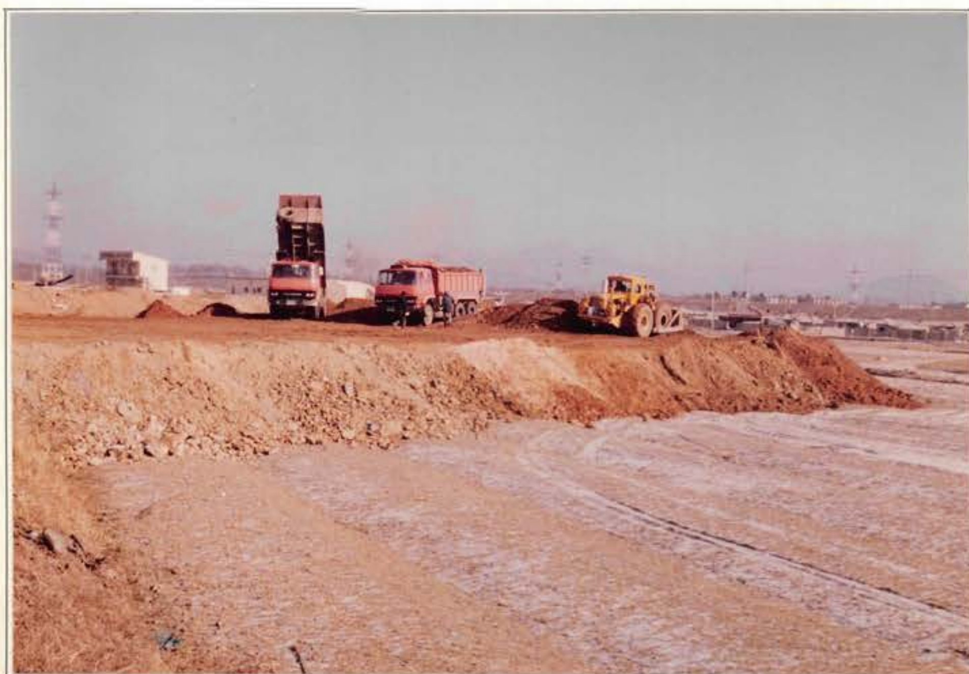
敷地造成全景
